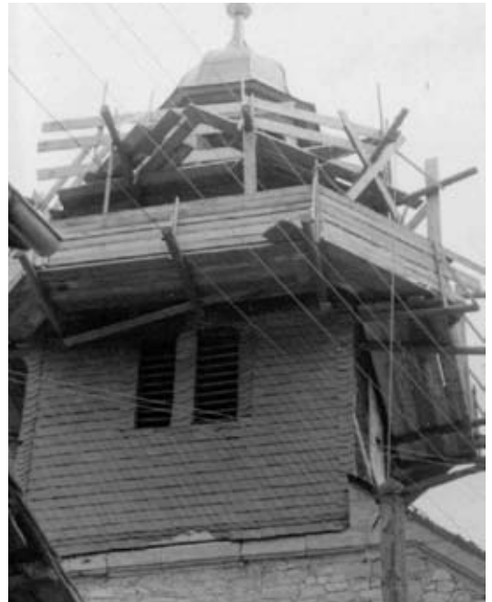
Neueindeckung des Kirchturmes 1981
