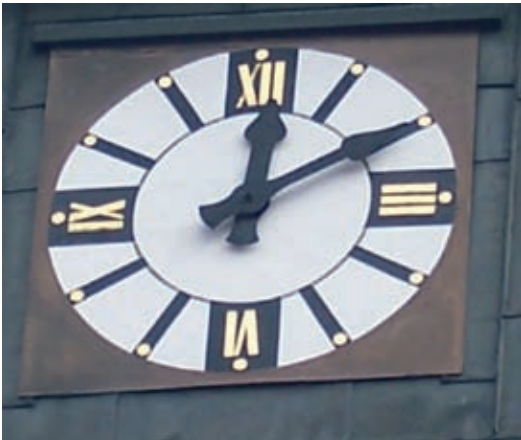
Kirchturmuhre nach der Renovierung 1997
